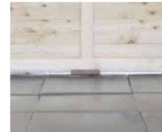
Standfüße für die Belüftung des Holzes aus Bankirai
